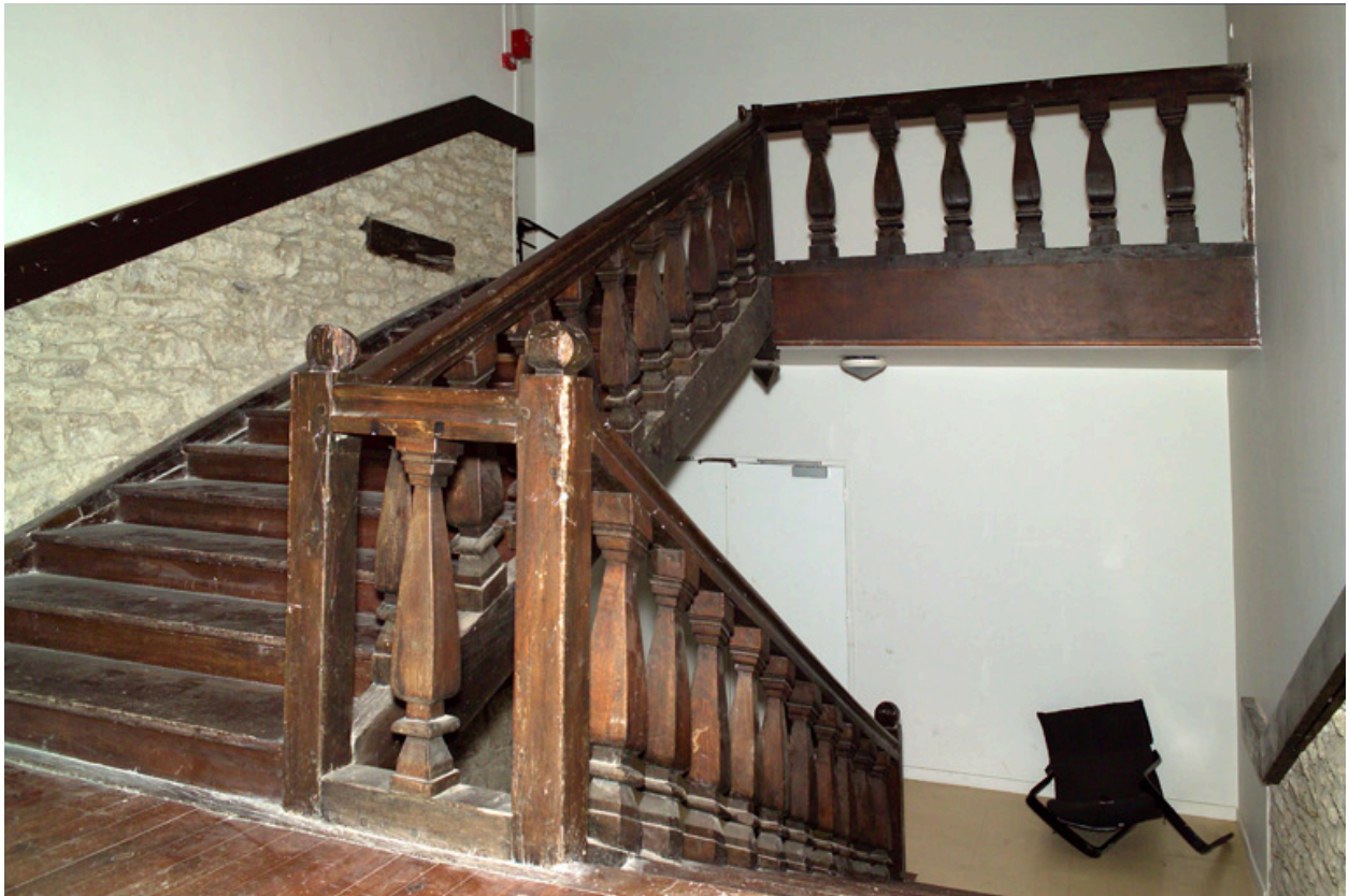
Escalier en bois du bâtiment est.
