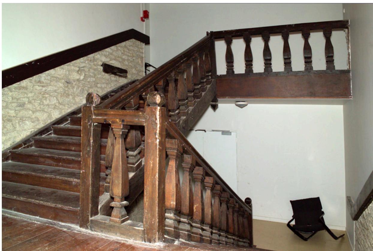
Escalier en bois du bâtiment est.
