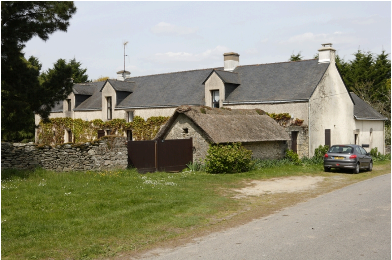
Vue depuis le sud.
