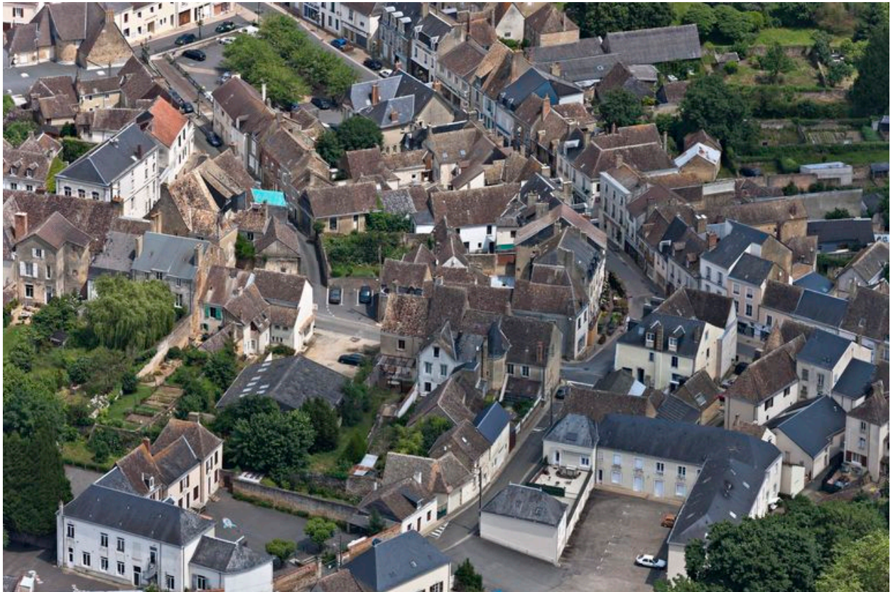
Vue aérienne depuis l'ouest (à droite).
