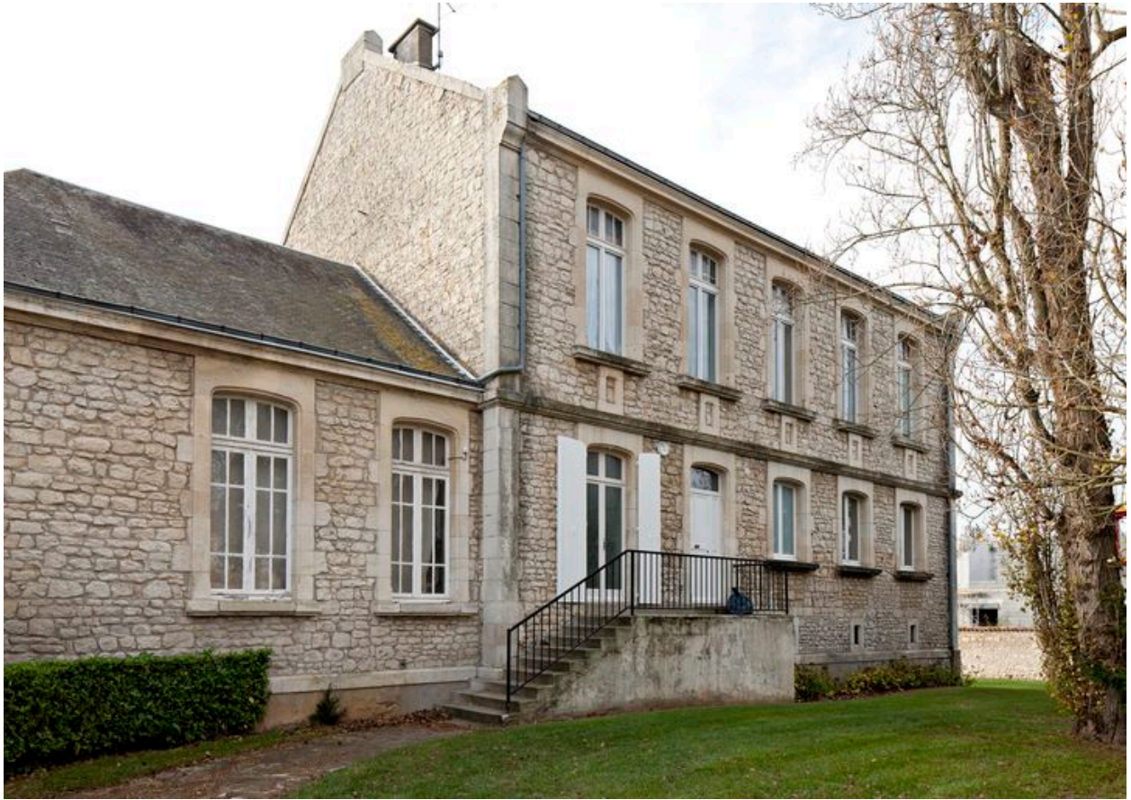
Bâtiment près de la rue de l'Asile (pour malades militaires contagieux à l'origine).
