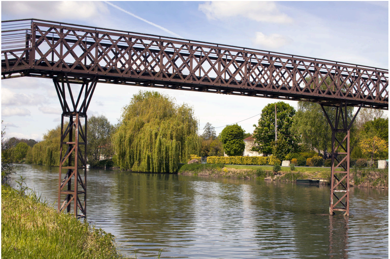
Détail de la passerelle vue en direction du nord-ouest.
