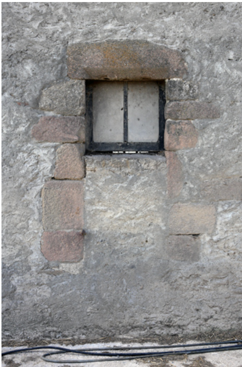
Logis. Façade est. Porte.
