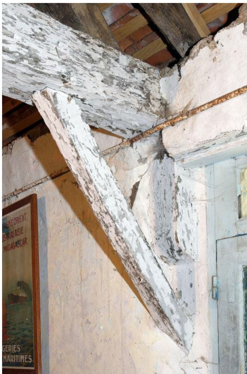
Détail de la charpente : l'entrait, le poteau central et le lien.
