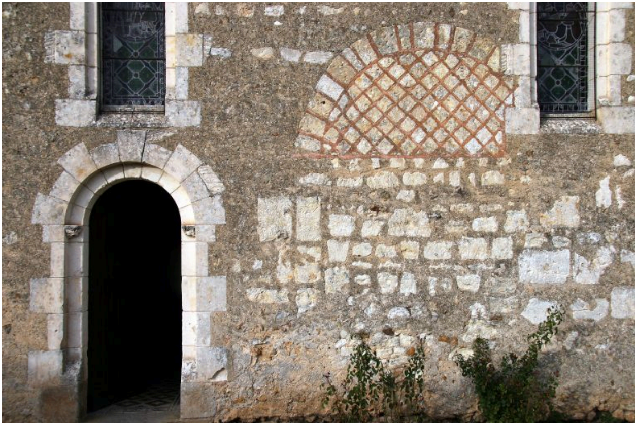
Façade méridionale de la nef : appareil réticulé.
