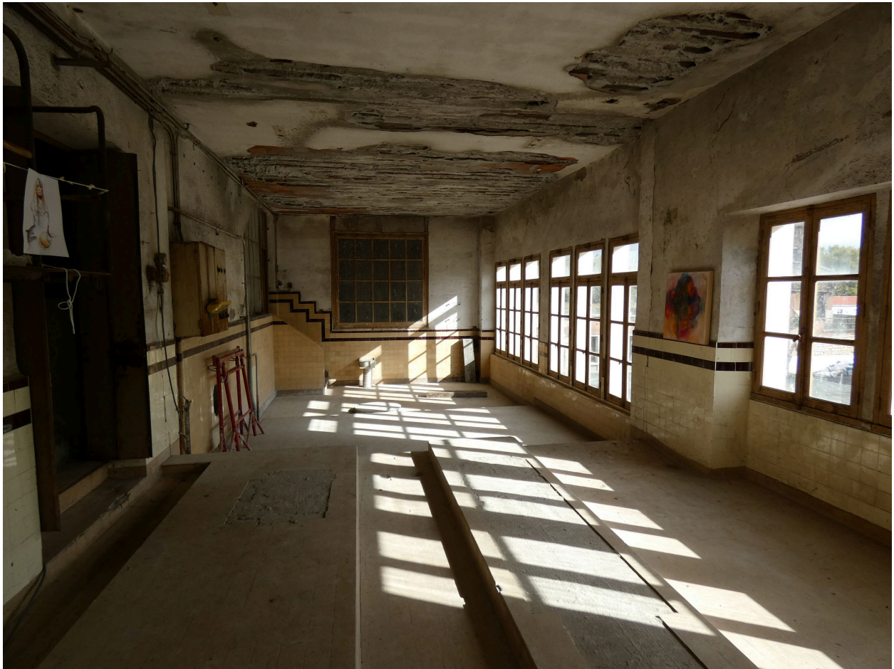
Salle à l'étage du magasin à poudre de lait et de la chaufferie, vue depuis le sud.
