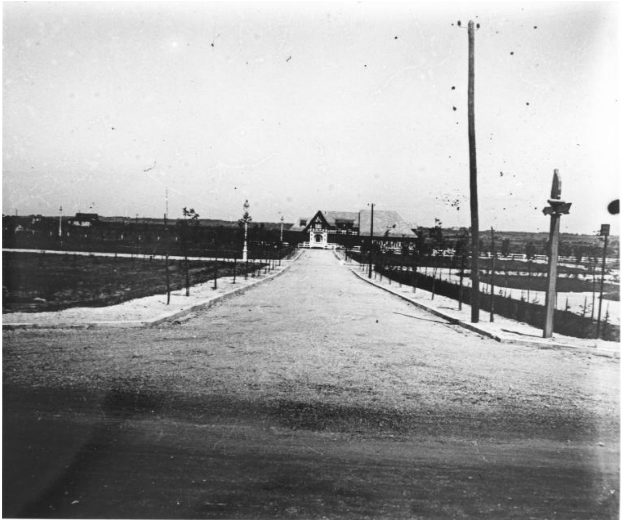
Façade sud du manège équestre Dassonville de François André en 1928.
