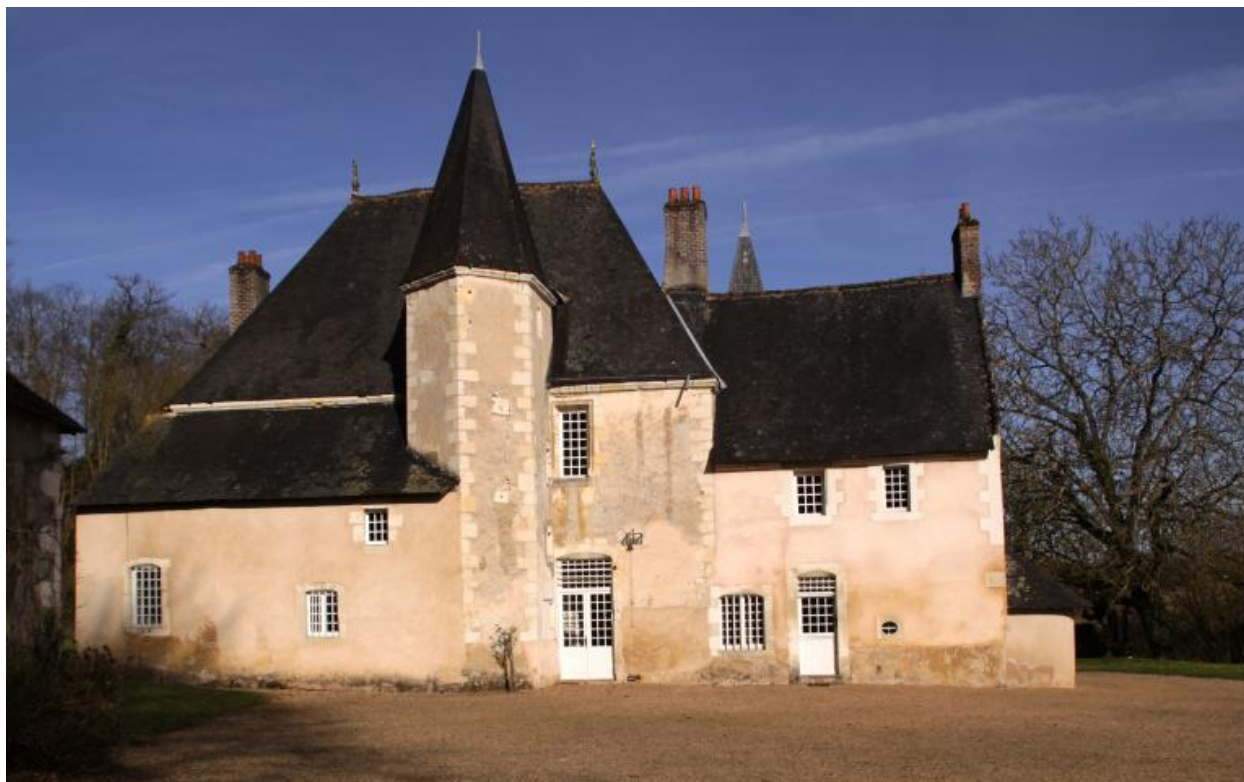
Façade sur cour (est).
