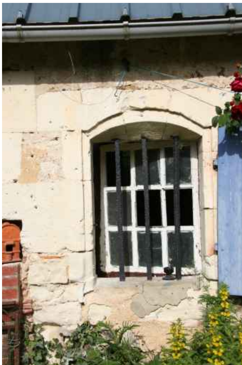
La maison : fenêtre de la chambre à feu.
