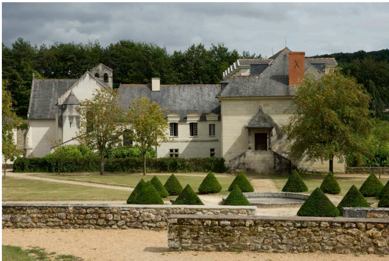
Prieuré Saint-Lazare, vue générale depuis l'ouest.
