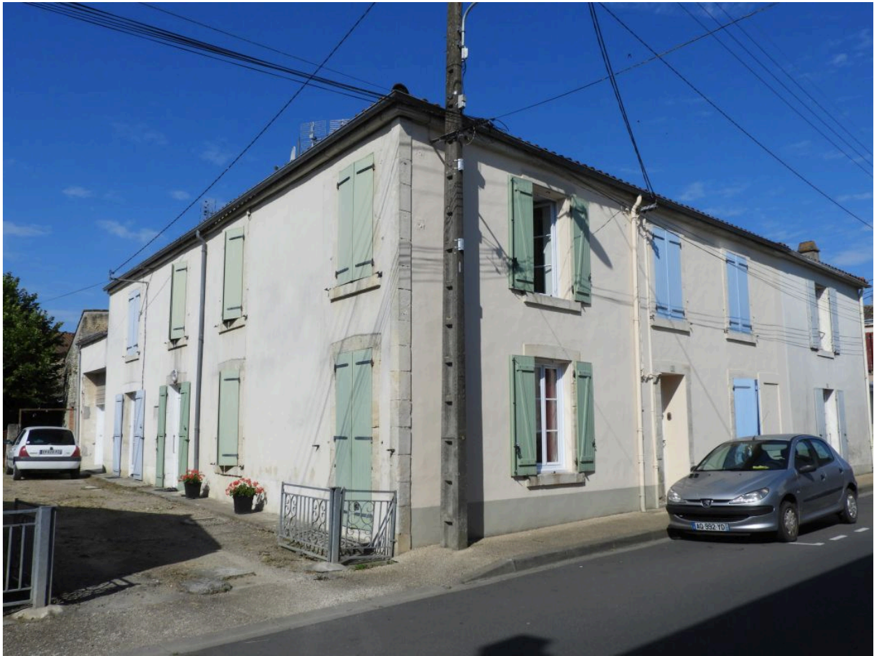
La maison vue depuis le nord-est.
