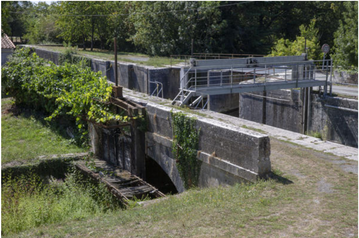
L'aqueduc vu côté amont, depuis le nord-est.
