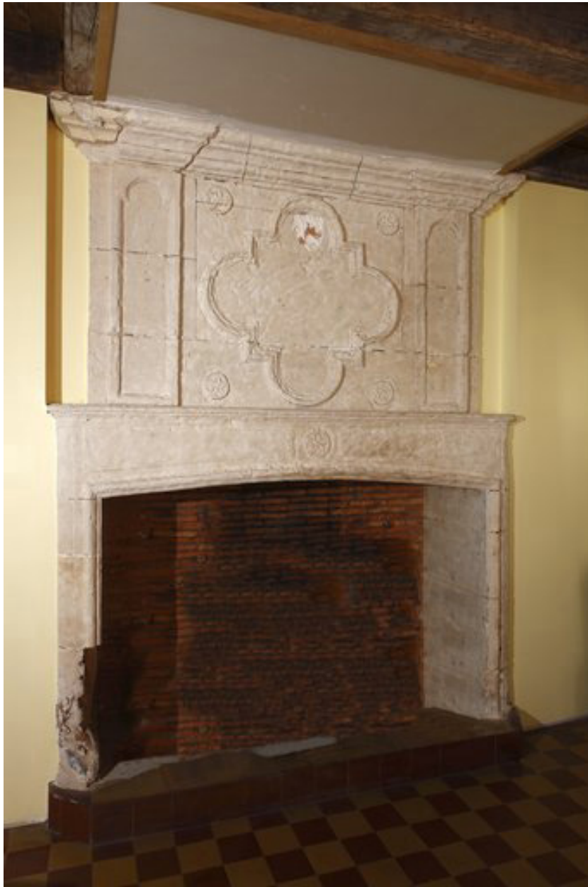
Cheminée du XVIIIe siècle, au rez-de-chaussée de la maison 27bis, rue des Gentilshommes.
