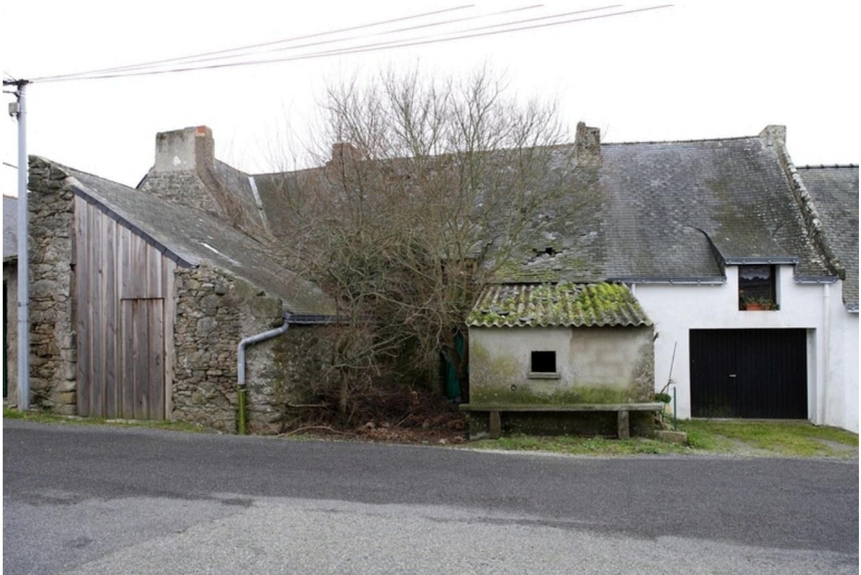
Vue du n° 7 rue du Rocher.
