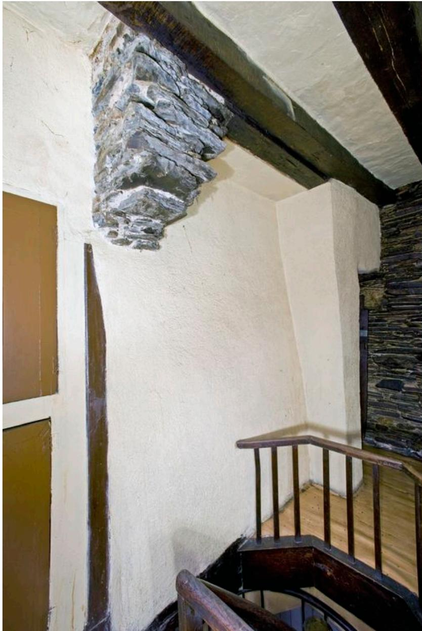
1er étage, petite pièce postérieure, face antérieure : maçonneries de schiste en renfort pour porter le conduit de la cheminée du 2e étage.
