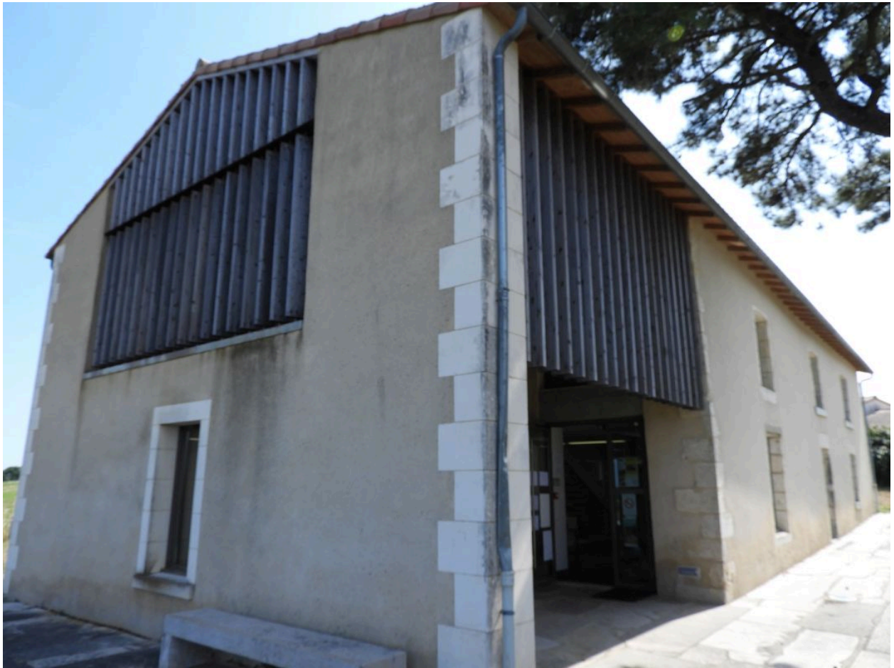
L'ancien hangar prolongeant le logis à l'ouest, vu depuis le sud-ouest.
