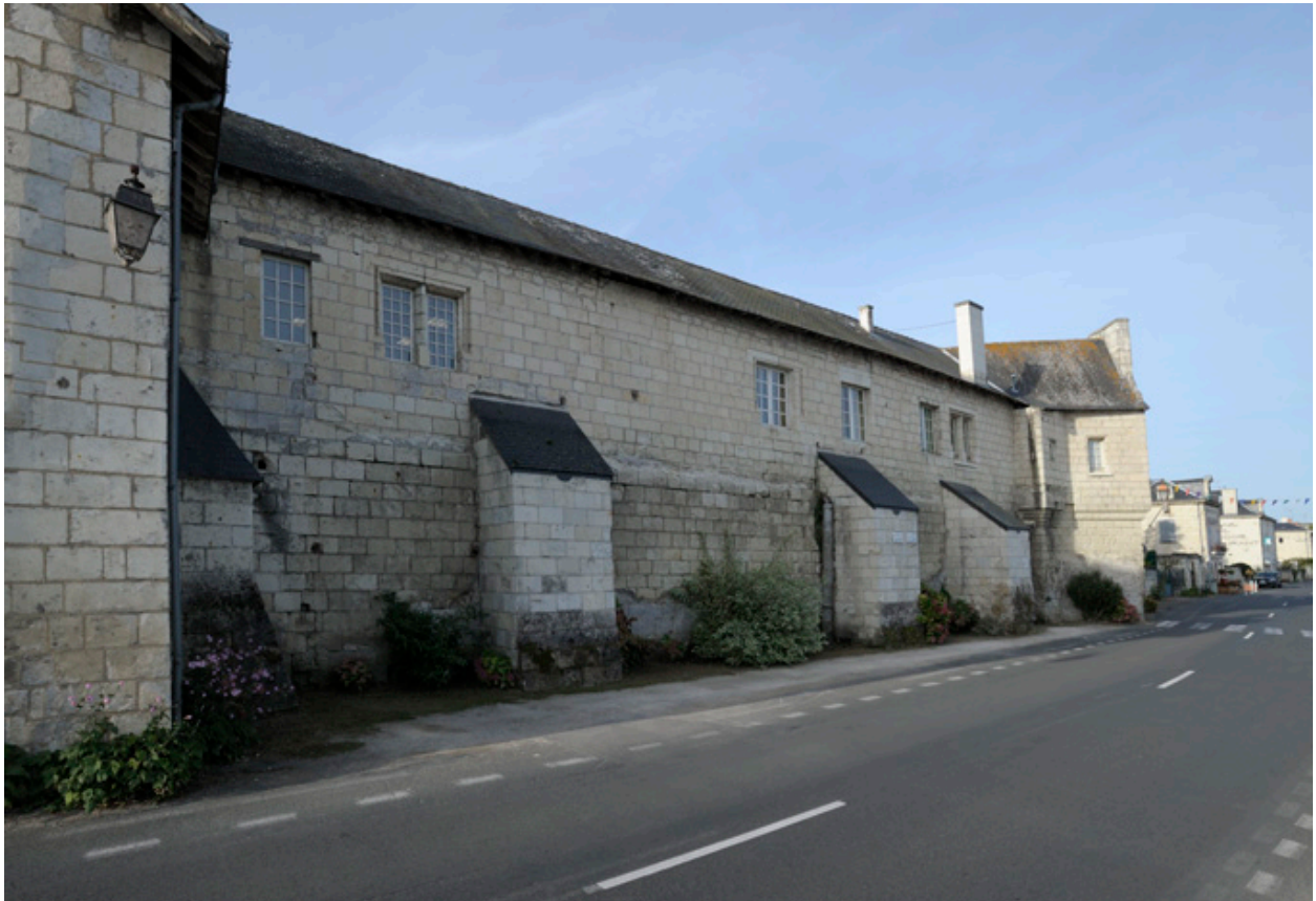
Façade sur Loire de l'actuelle école, anciennement logements et écuries.
