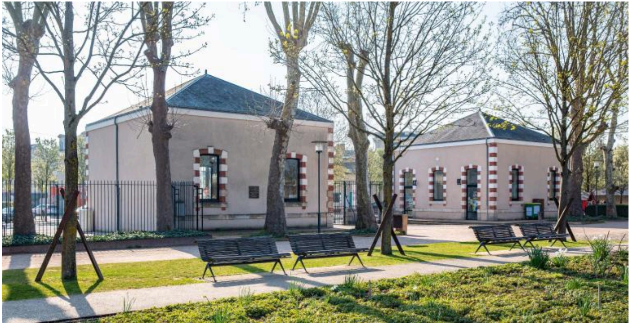
Vue des pavillons d'entrée de la caserne Chanzy.
