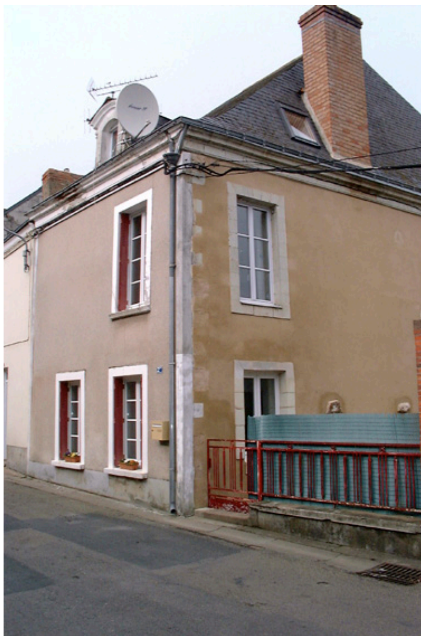
Maison. 18e siècle. Remaniée au 19e siècle.
