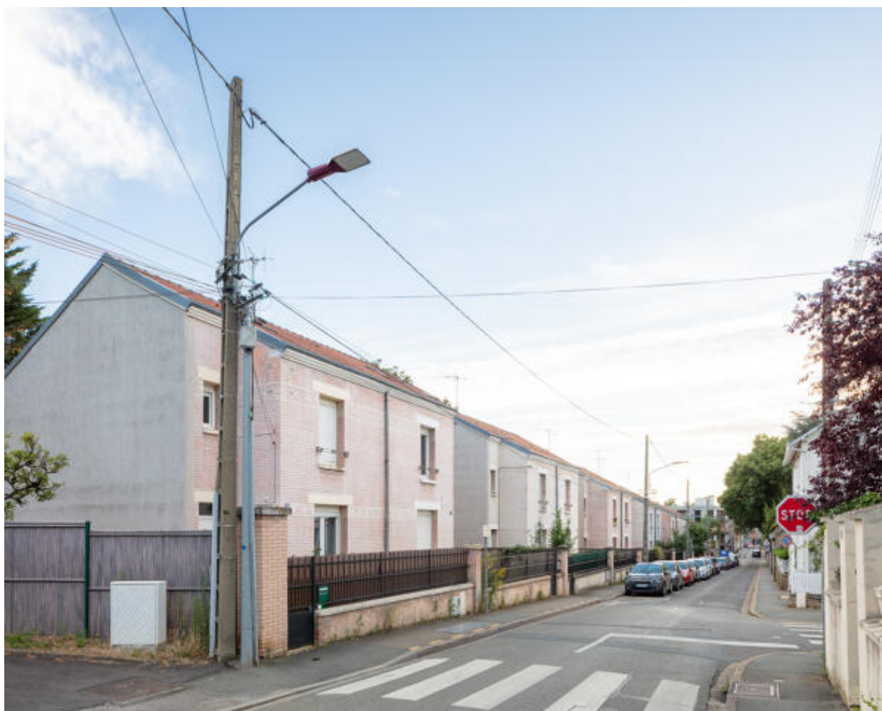
Vue des maisons économiques rue de l'Eventail.
