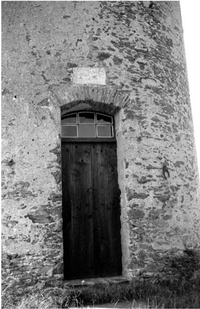
Détail de la porte nord en 1972.
