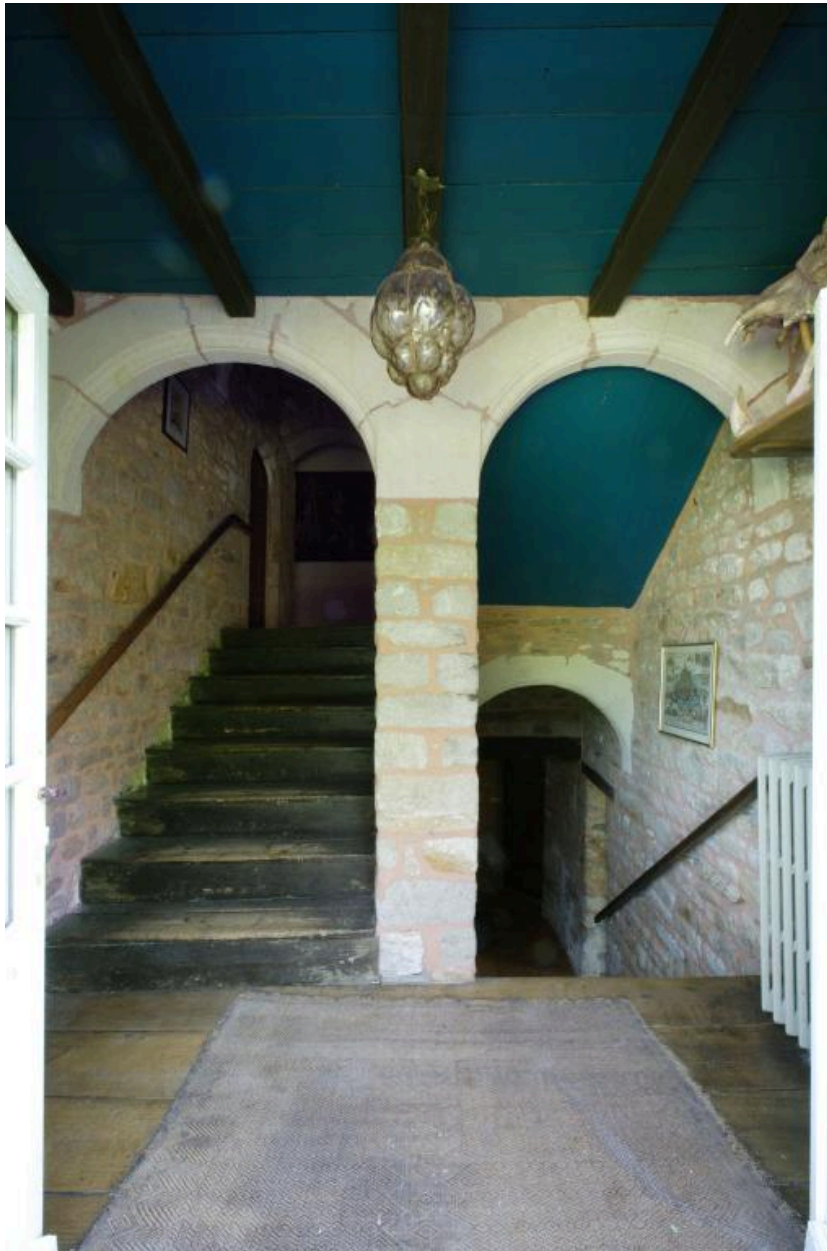
Logis. Cage d'escalier. Vue du premier repos.
