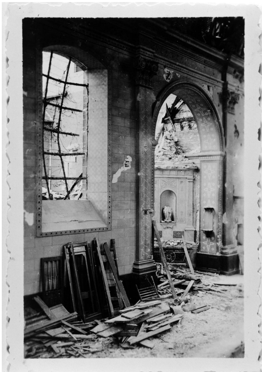
Ruines de l'église après bombardement : nef, mur ouest et entrée de la chapelle de la Sainte Vierge, fotogr., 1944.
