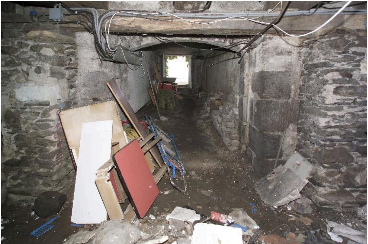
Le niveau des caves, la sortie sur le quai.
