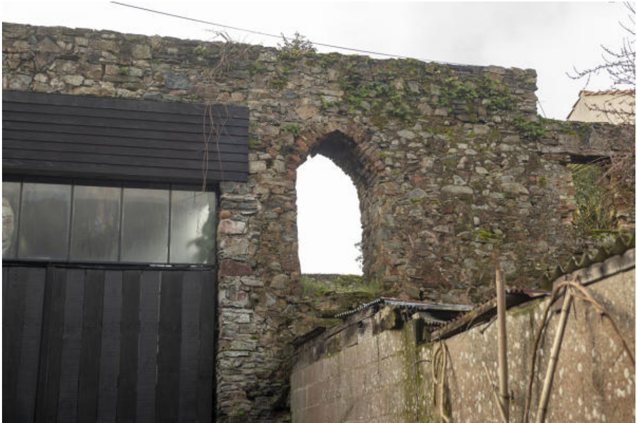
Ancien entrepôt. Détail d'une ouverture.
