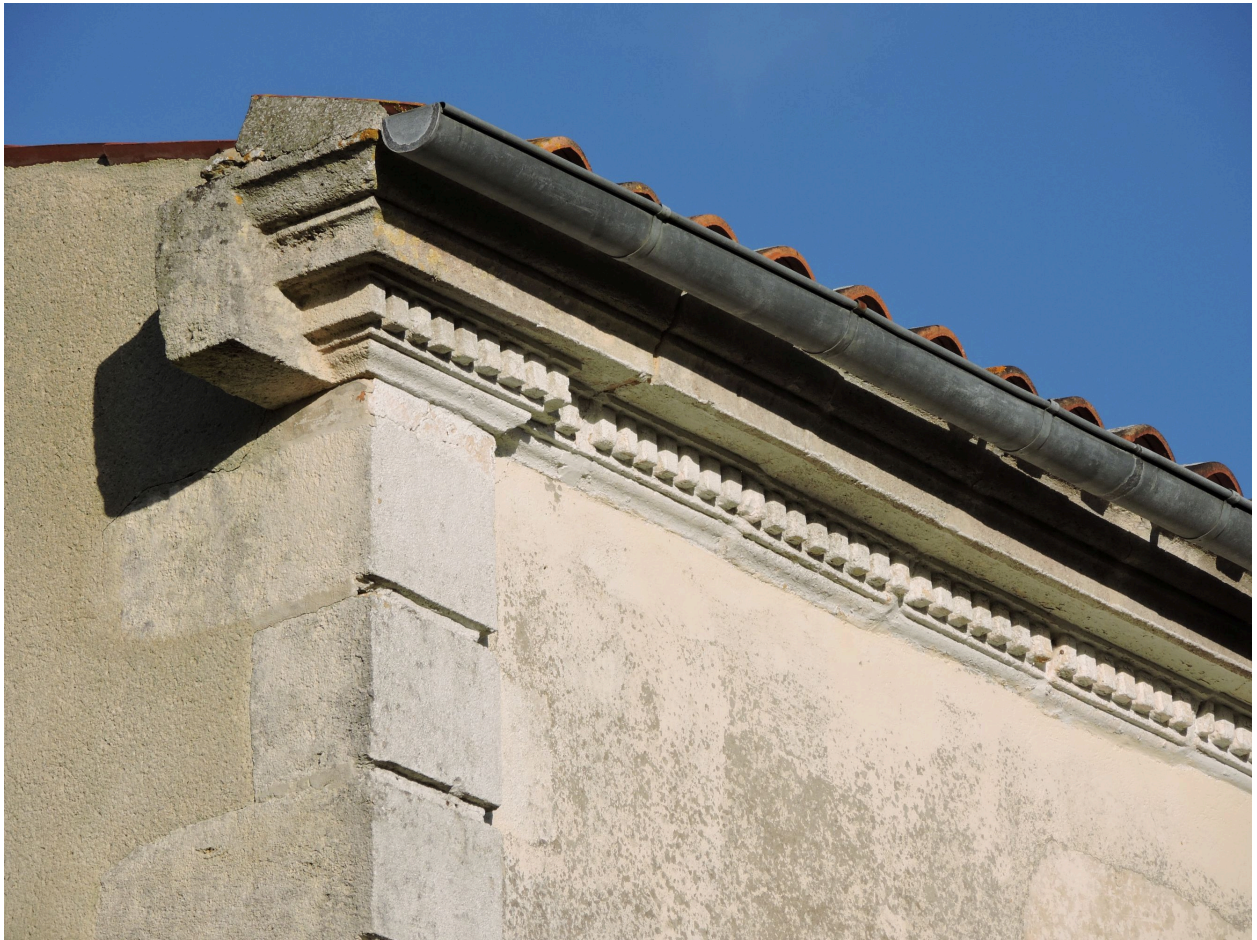
Détail de la corniche à denticules.
