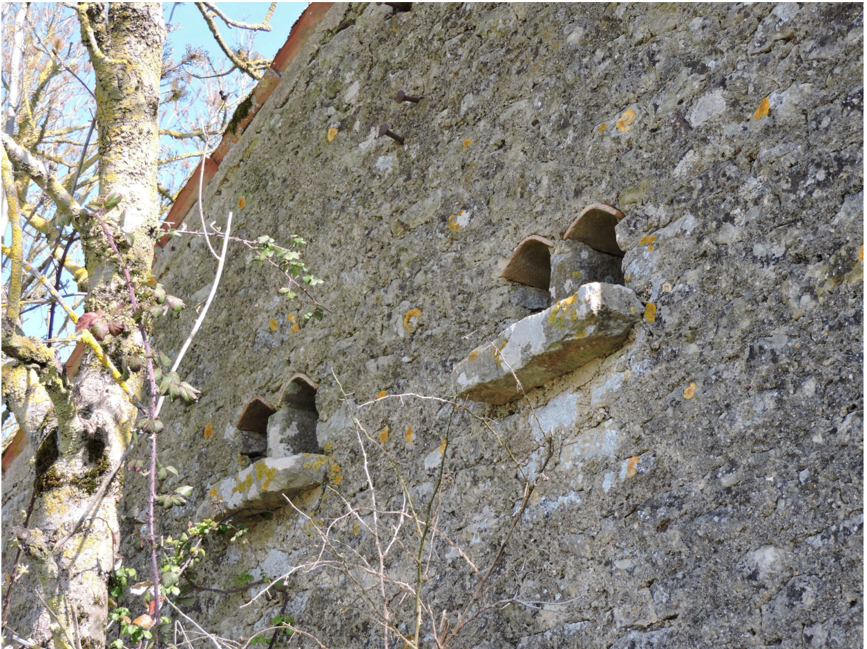
Boulins à pigeons sur le mur pignon sud-ouest de la grange sud.
