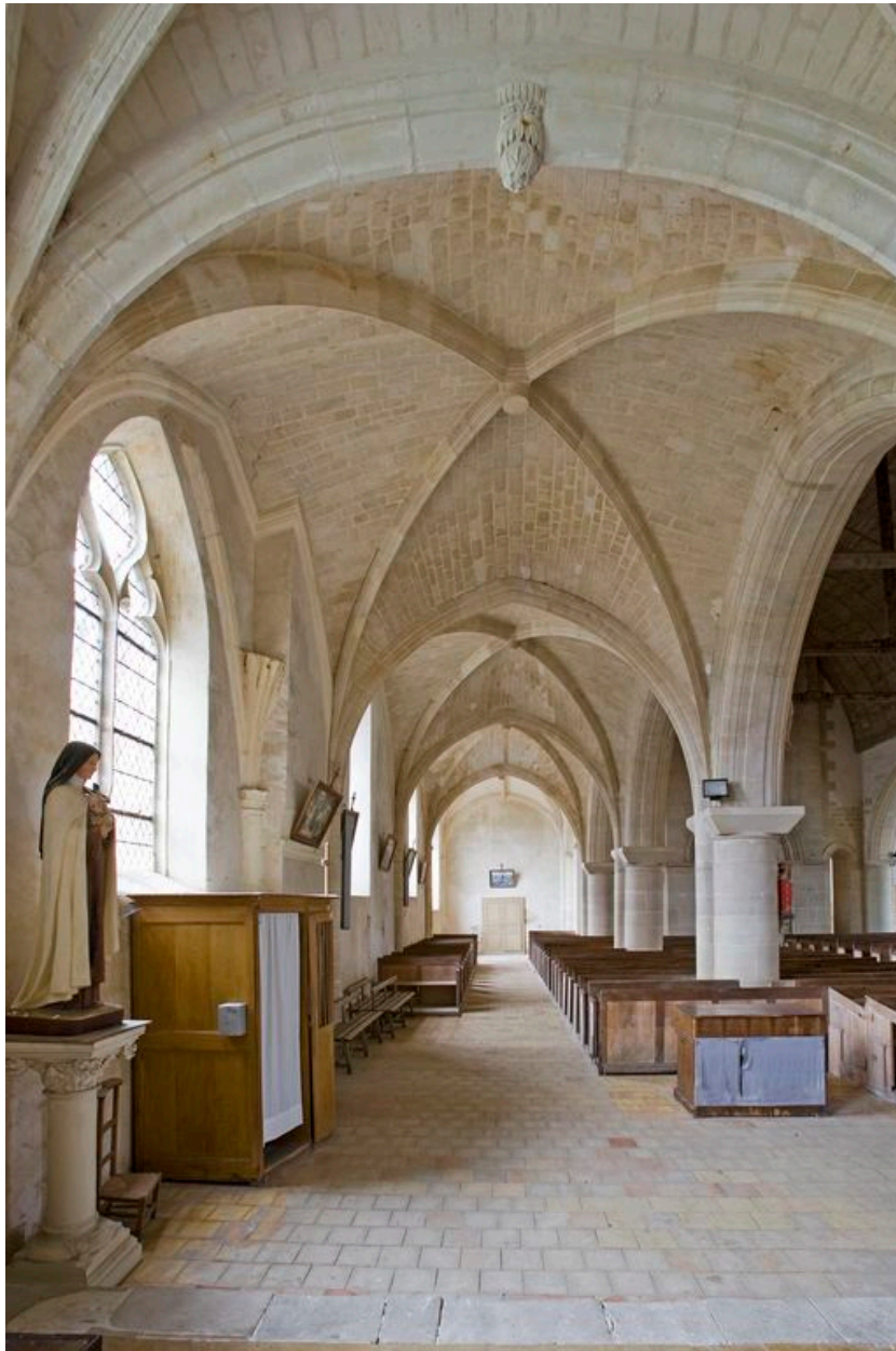
Bas-côté sud, vu depuis l'est
