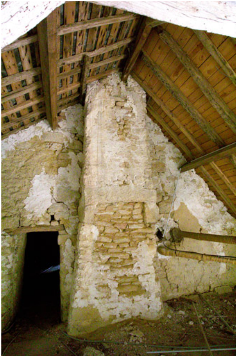
Conduit de cheminée dans le comble au-dessus de la petite pièce centrale du logis.
