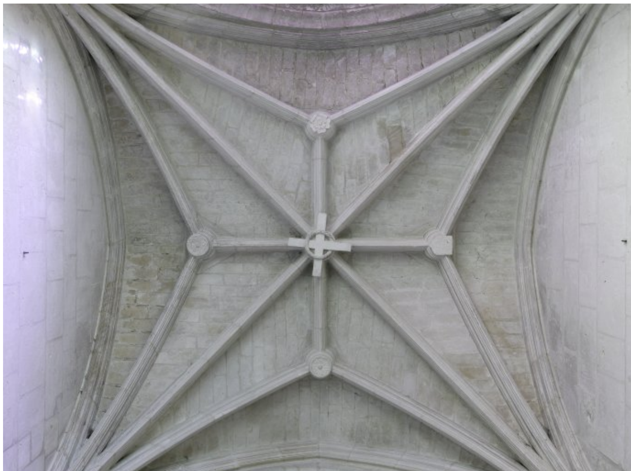
Première chapelle du bas-côté sud de la nef : vue de la voûte.
