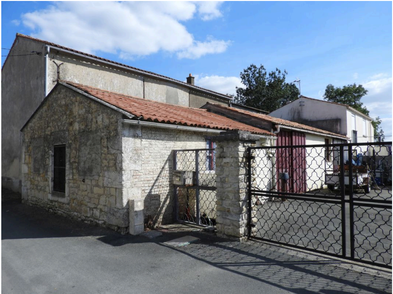
Les bâtiments vus depuis le nord-ouest.
