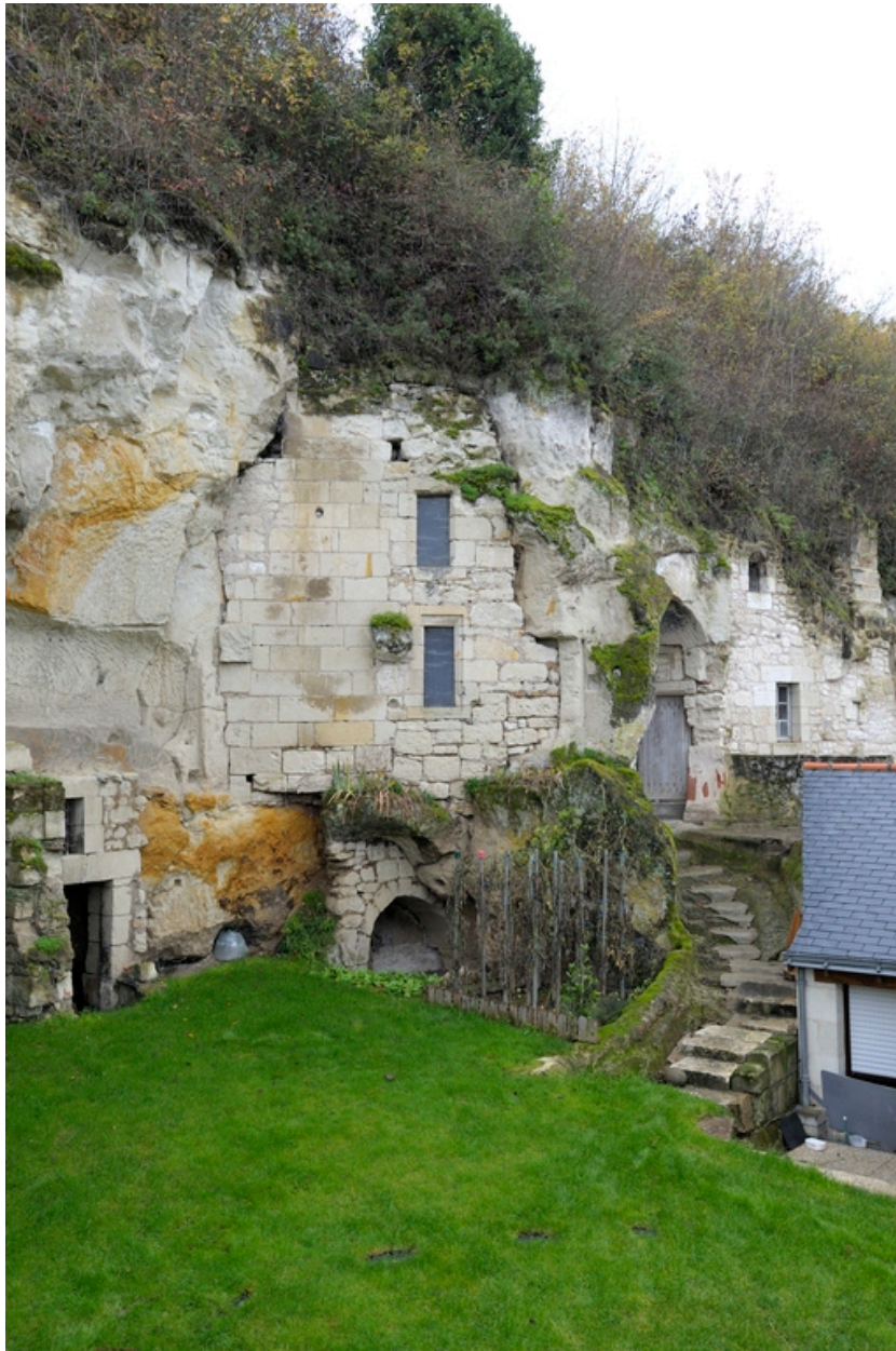
Vue de l'abri troglodytique, façade nord-ouest (remaniements du 15e au 18e siècle).
