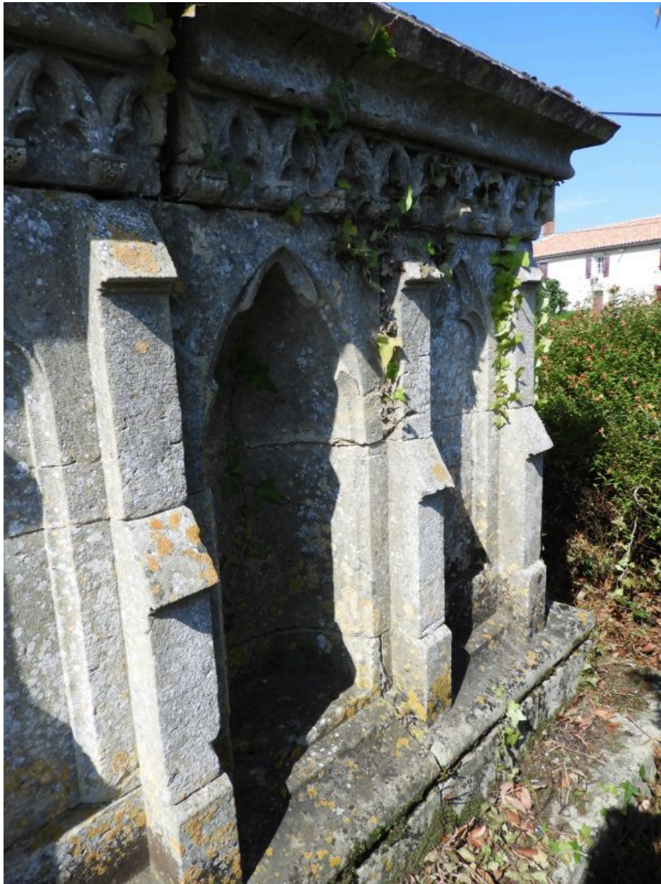
Détail du socle, côté nord-est.
