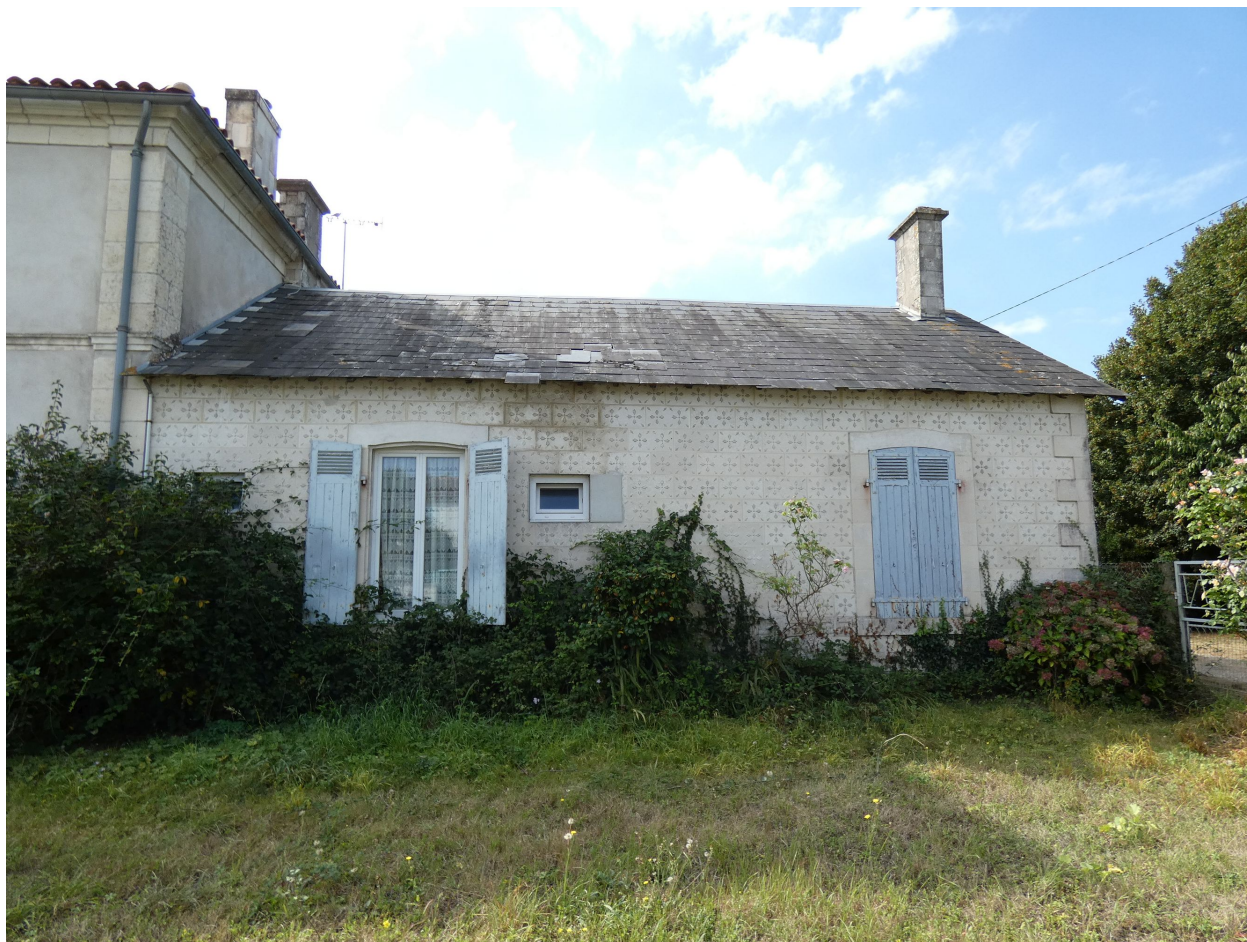
L'extension du logis à l'ouest, vue depuis le nord.
