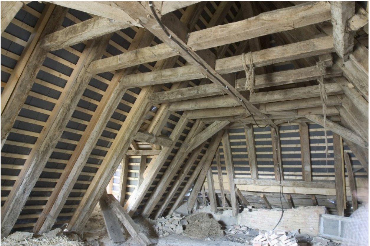
Intérieur du logis, comble du pavillon : la charpente.
