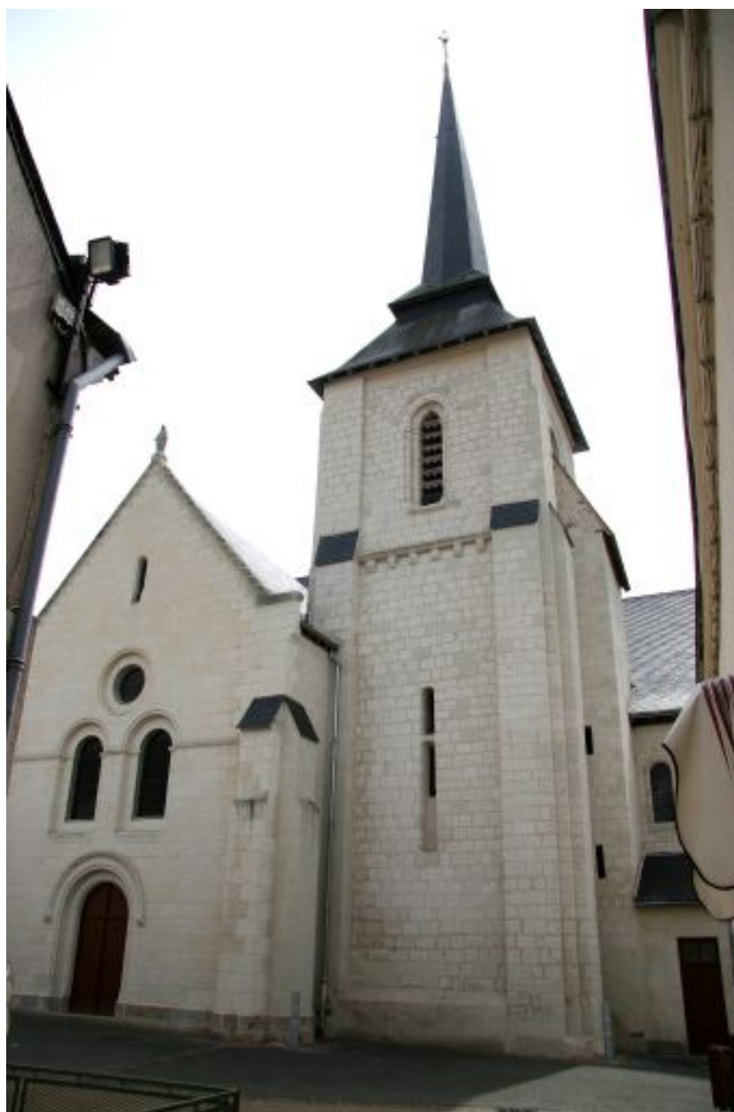
Eglise paroissiale, façade nord : le clocher.
