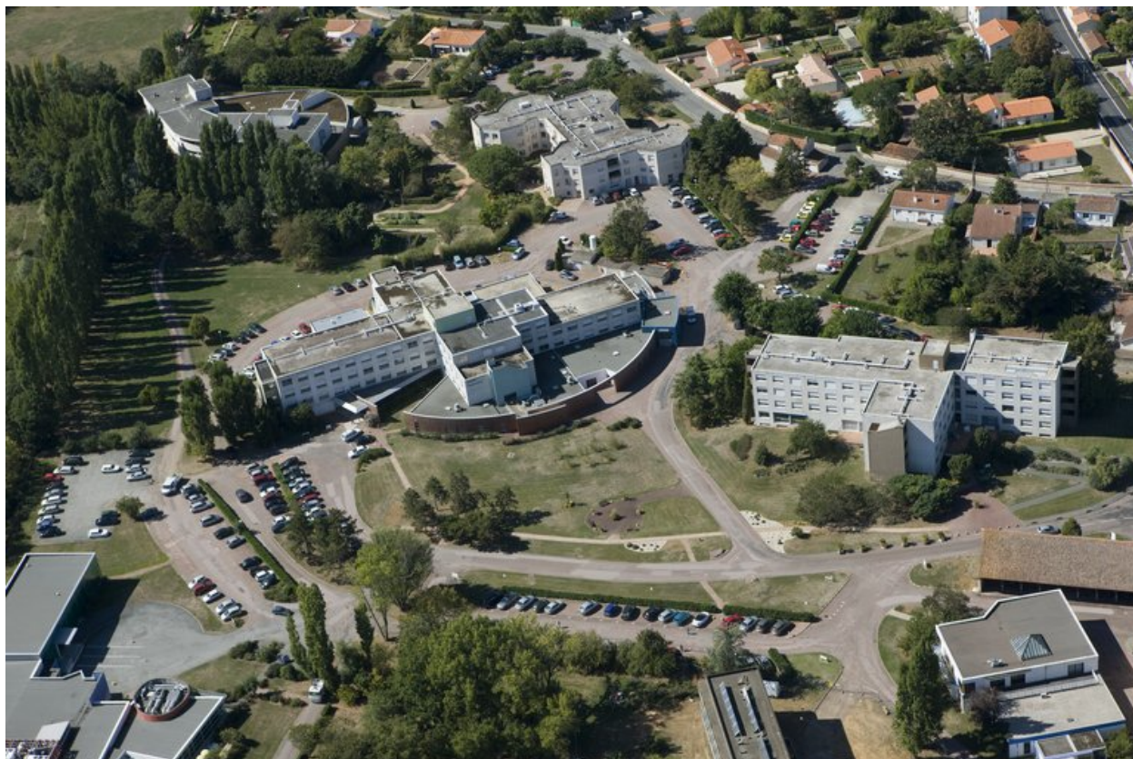
Vue aérienne prise de l'est, montrant les équipements récents.
