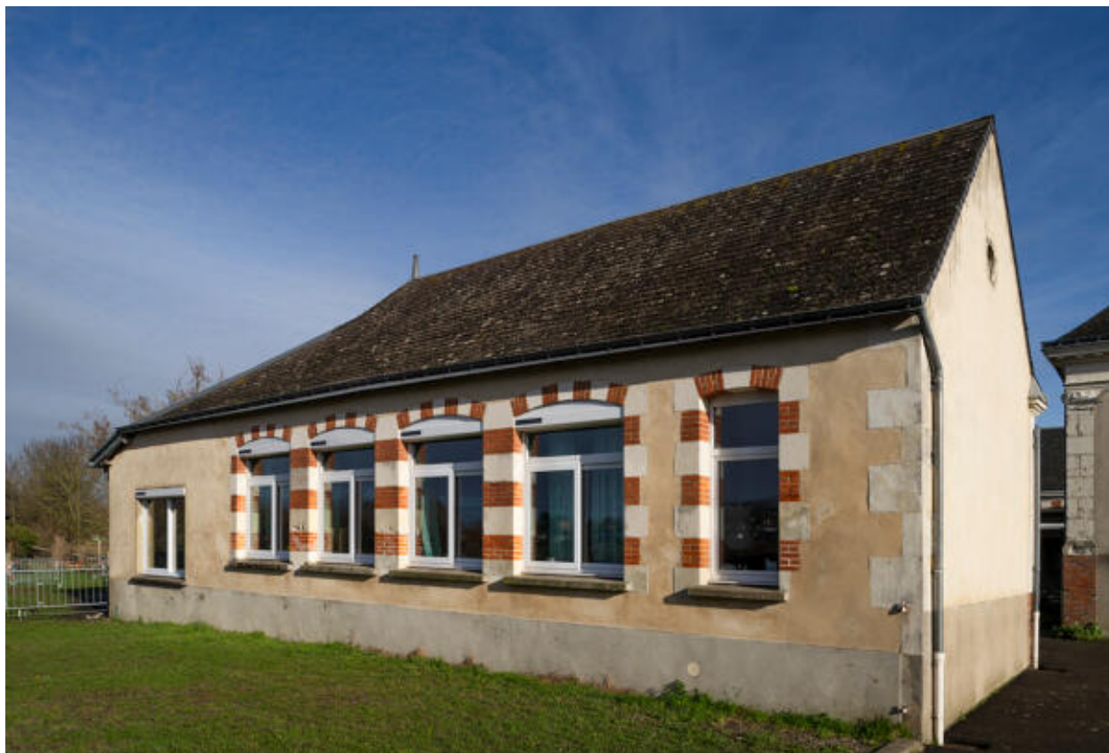
Élévation postérieure de l'aile gauche des classes.
