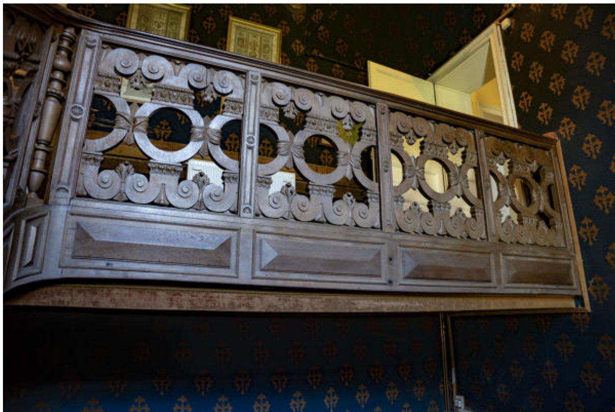
L'escalier d'honneur, détail du garde-corps.
