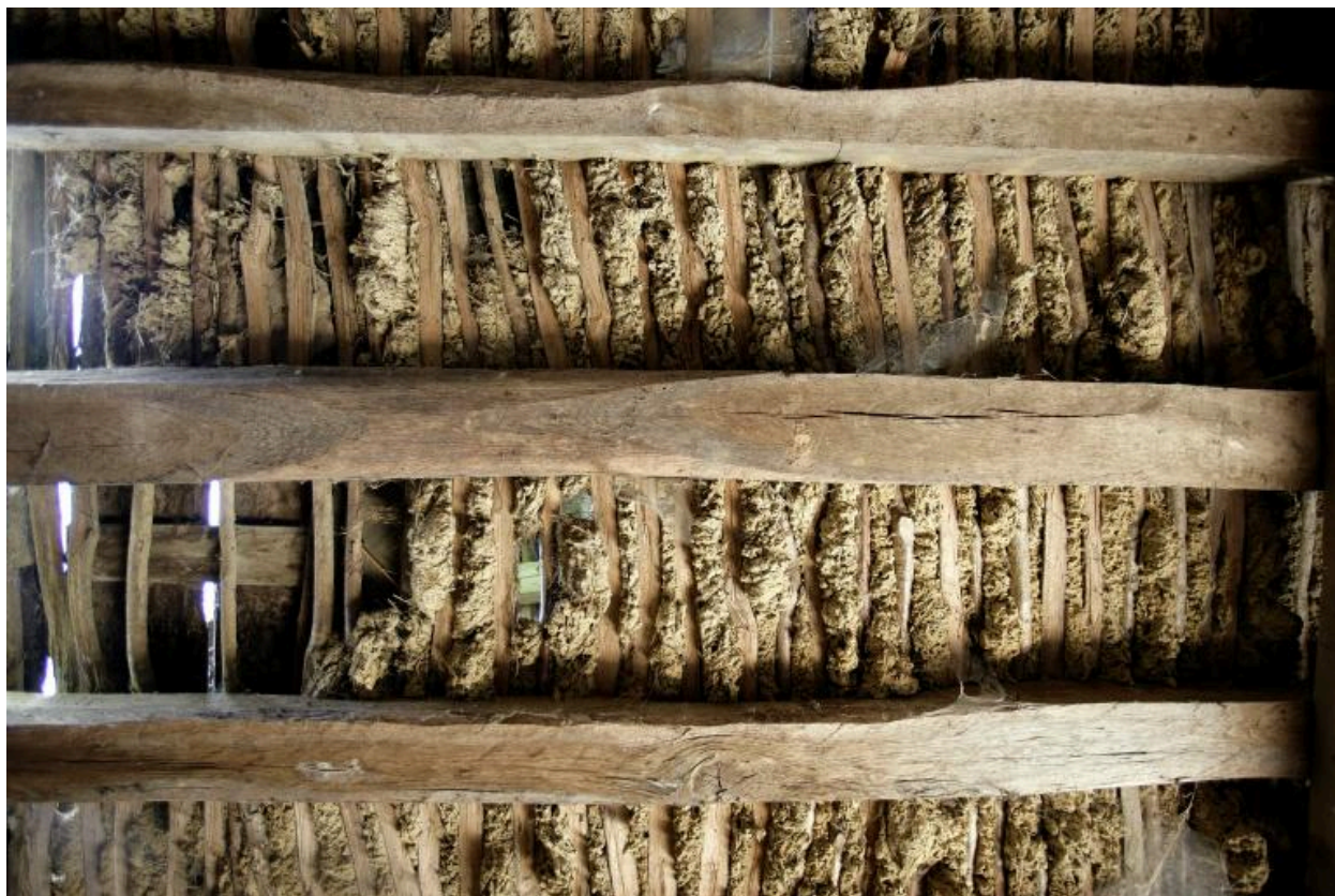
Logis, remise : détail du plafond.
