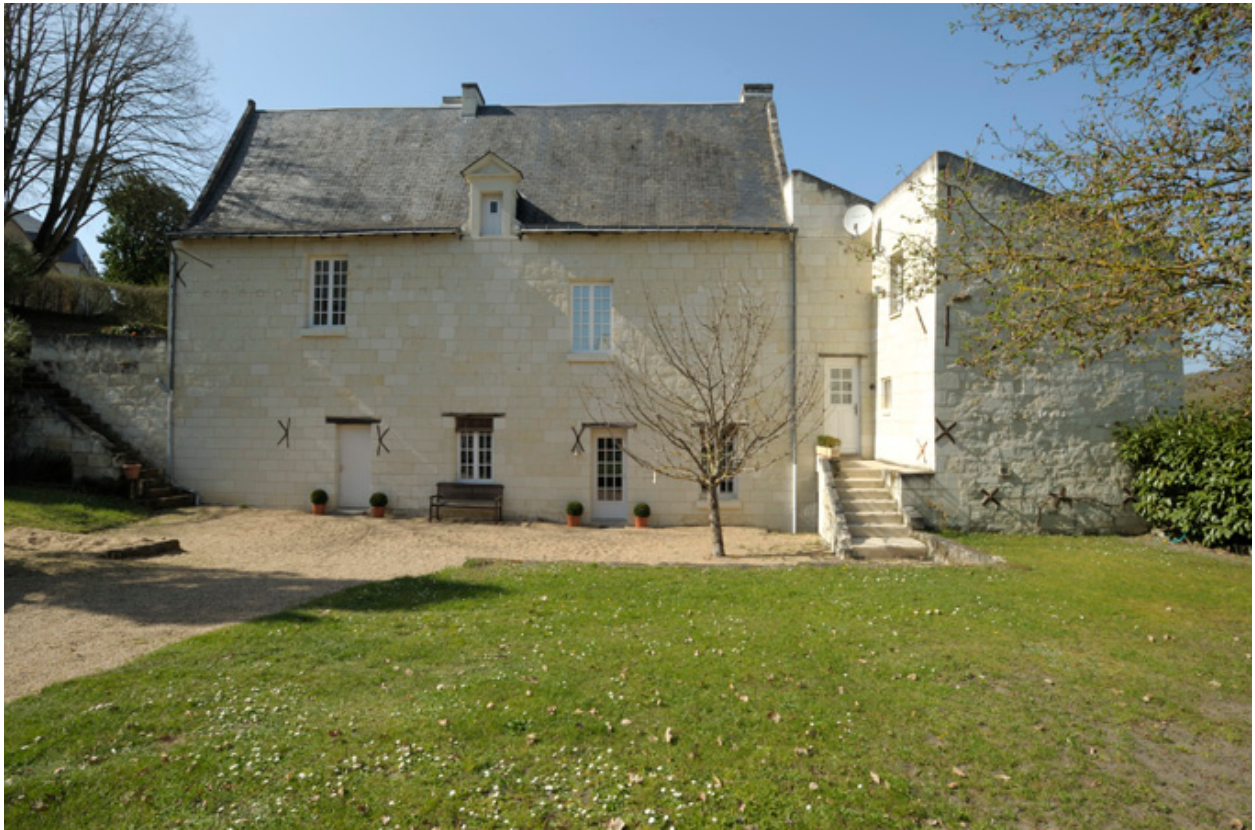
Façade principale, sur cour.
