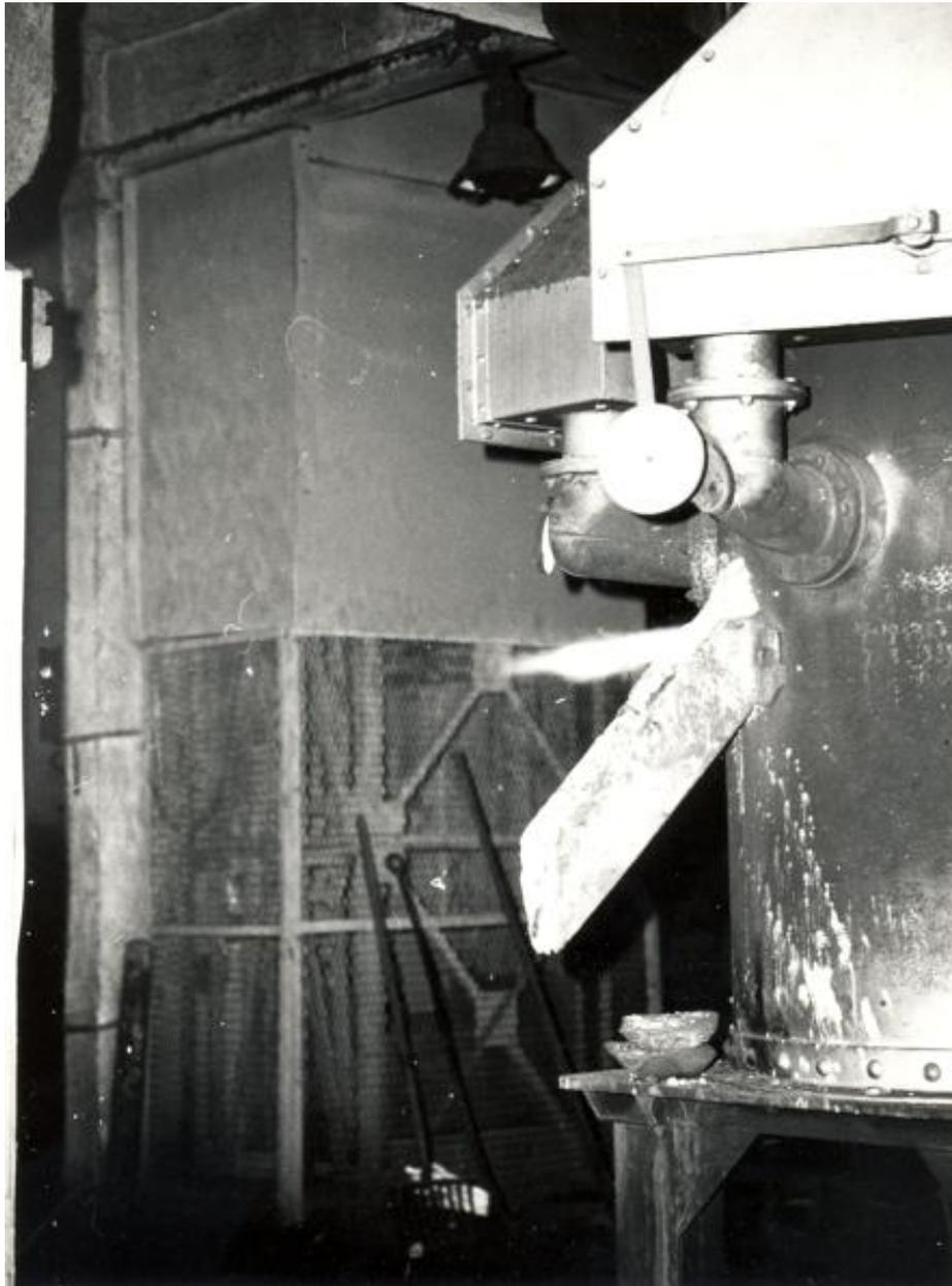
Atelier de fonderie : base du cubilot gauche. Tuyère d'écoulement du laitier.
