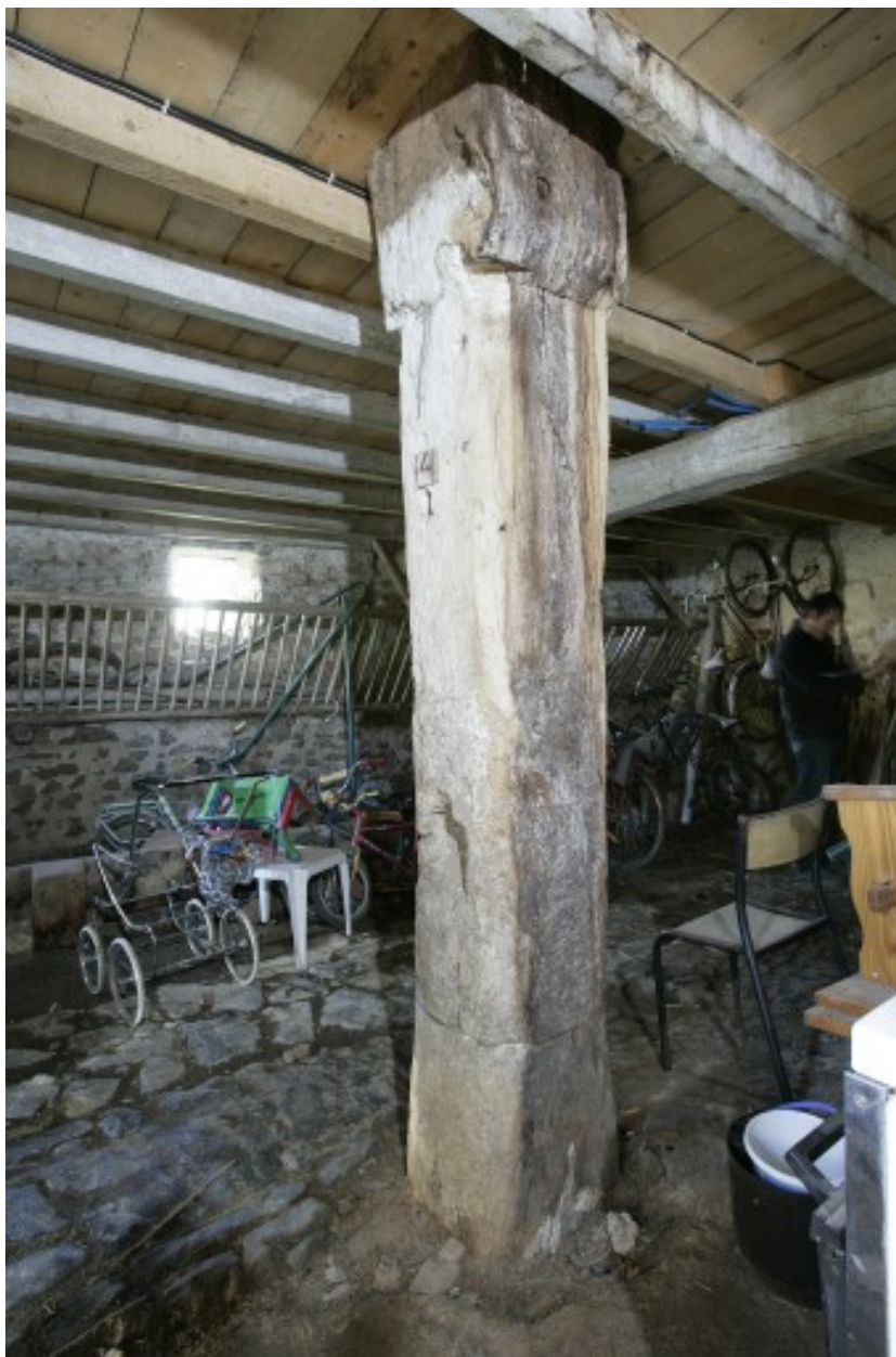
Grange-étable : la partie inférieure du poteau nord-est vu depuis le nord-ouest.
