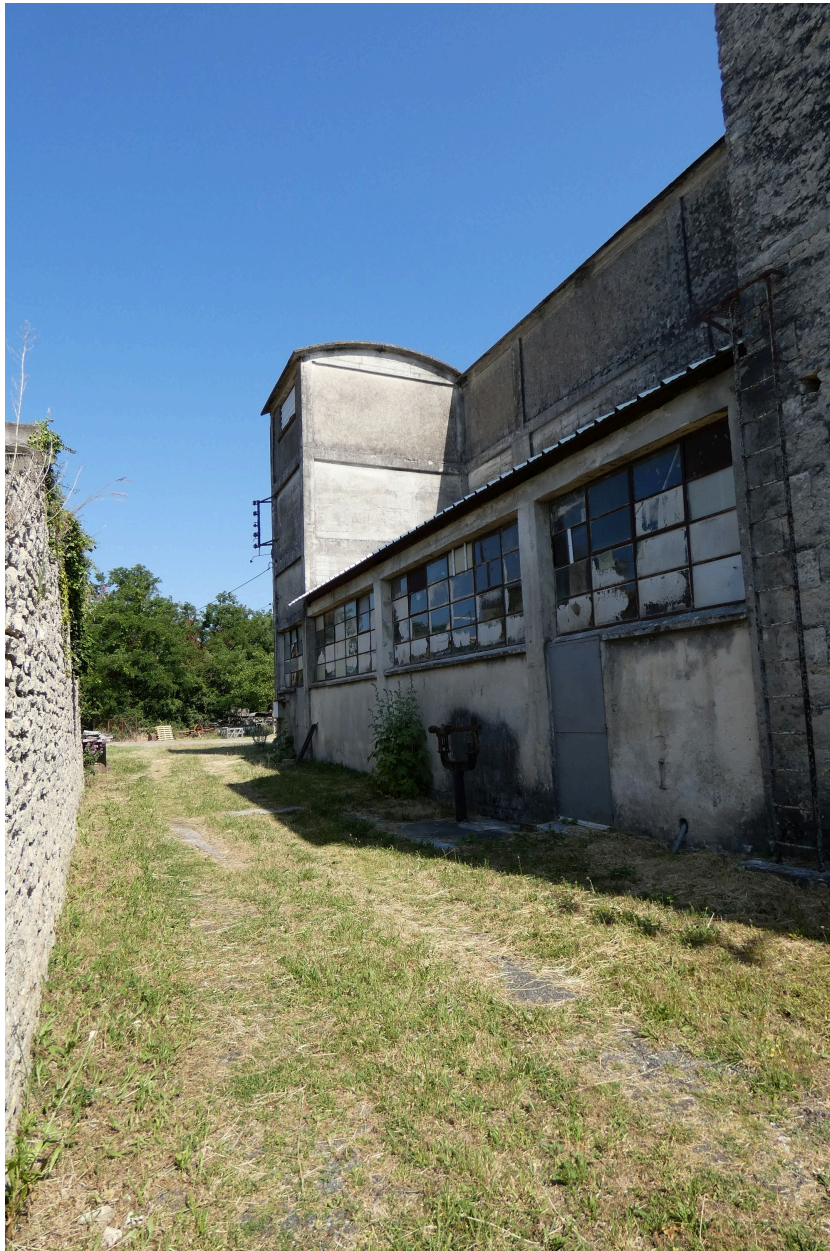
Ancien passage des rails le long de la bluterie, côté sud, vu depuis le sud-est.
