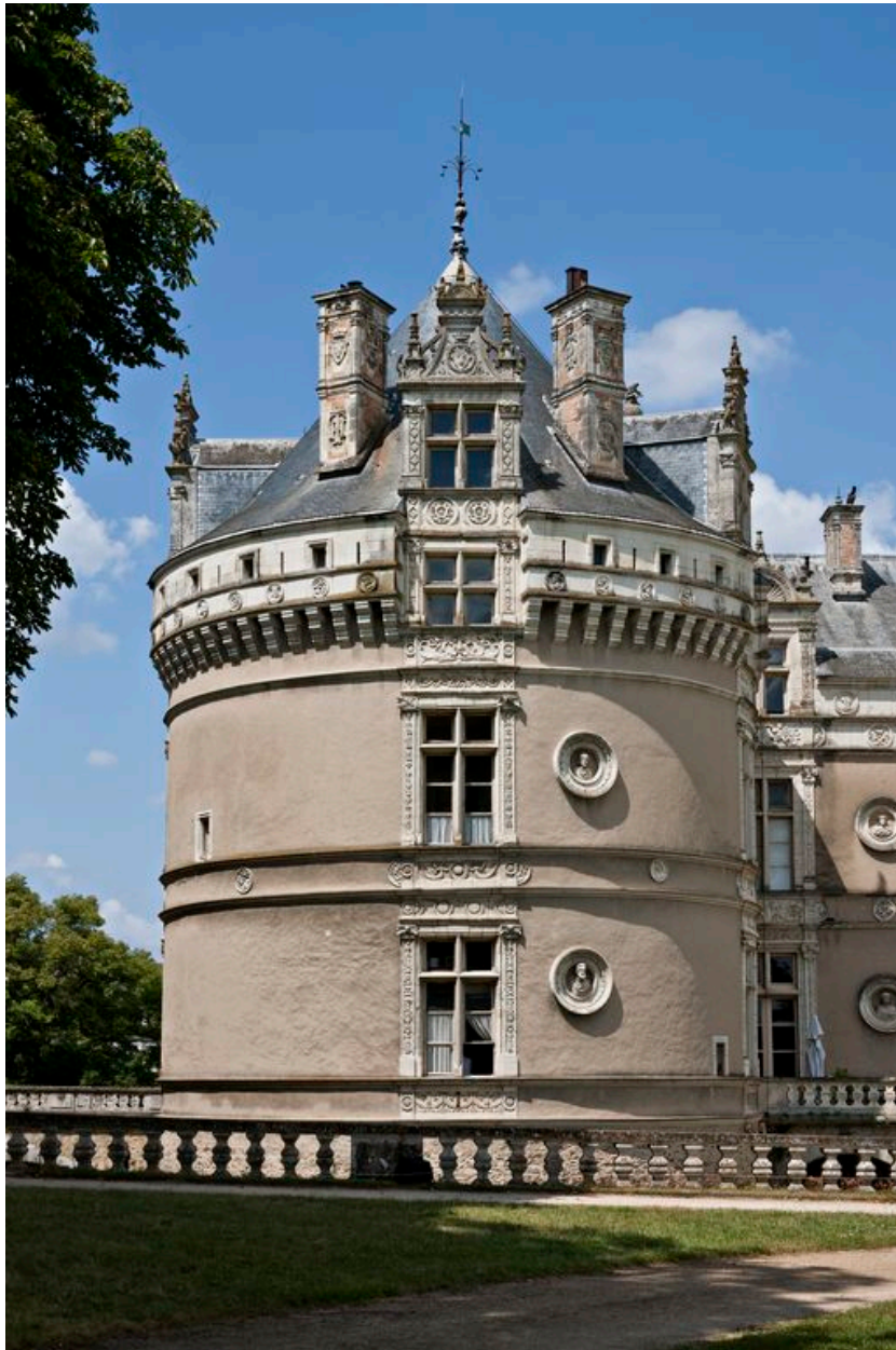
Aile sud, tour sud-ouest : travée de baies sud.
