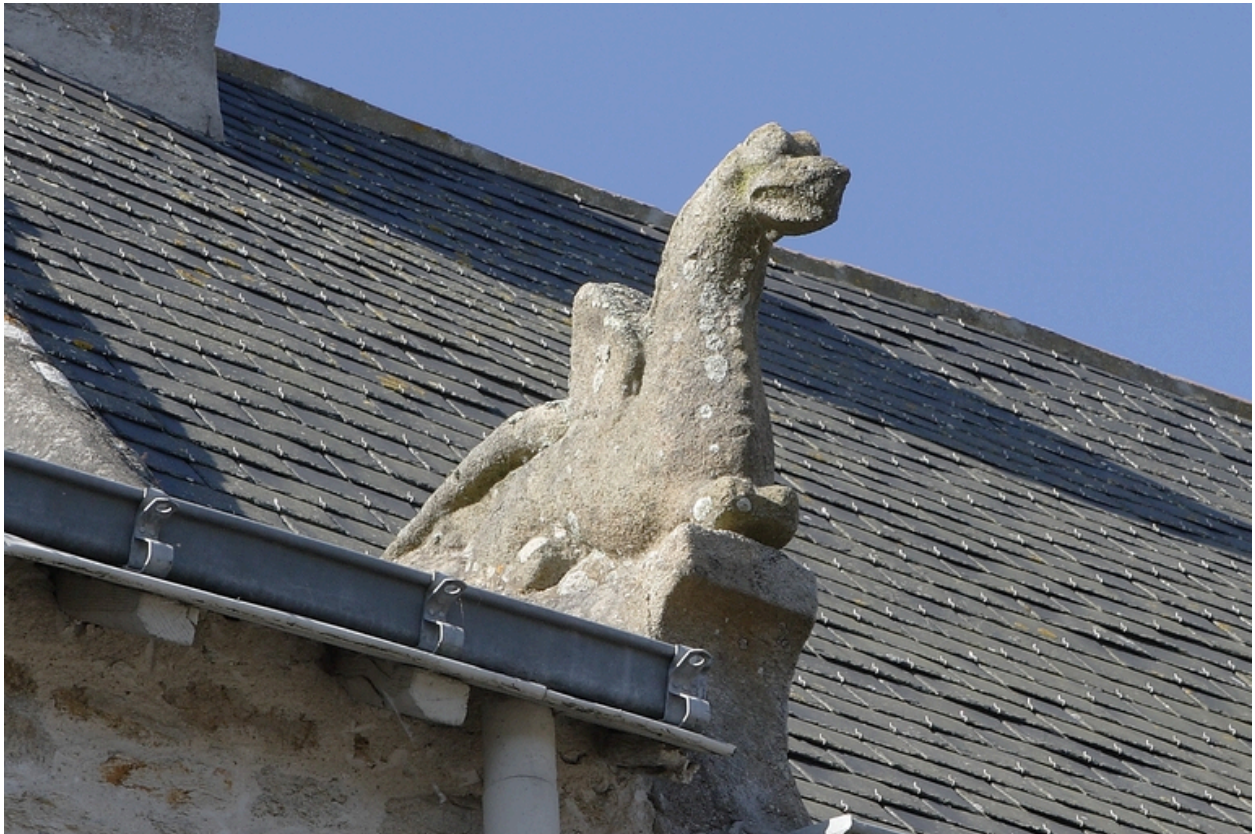
Maison n° 8 rue du Four. Façade nord. Détail de la crossette.
