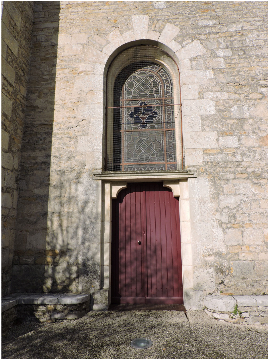
La porte sud-est et la baie qui la surmonte.
